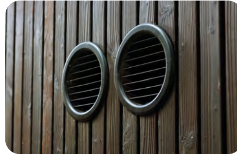
Airco-doorvoeren
